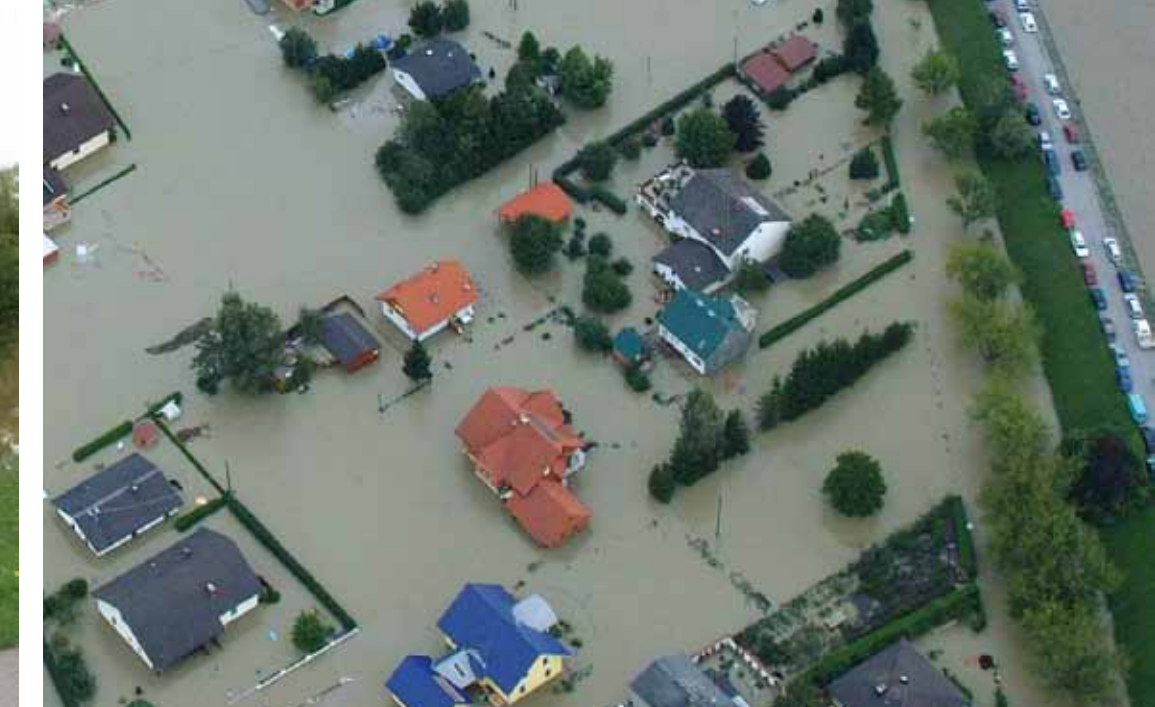
Damm-Auffahrt Höhe Hydraulik Wurm
