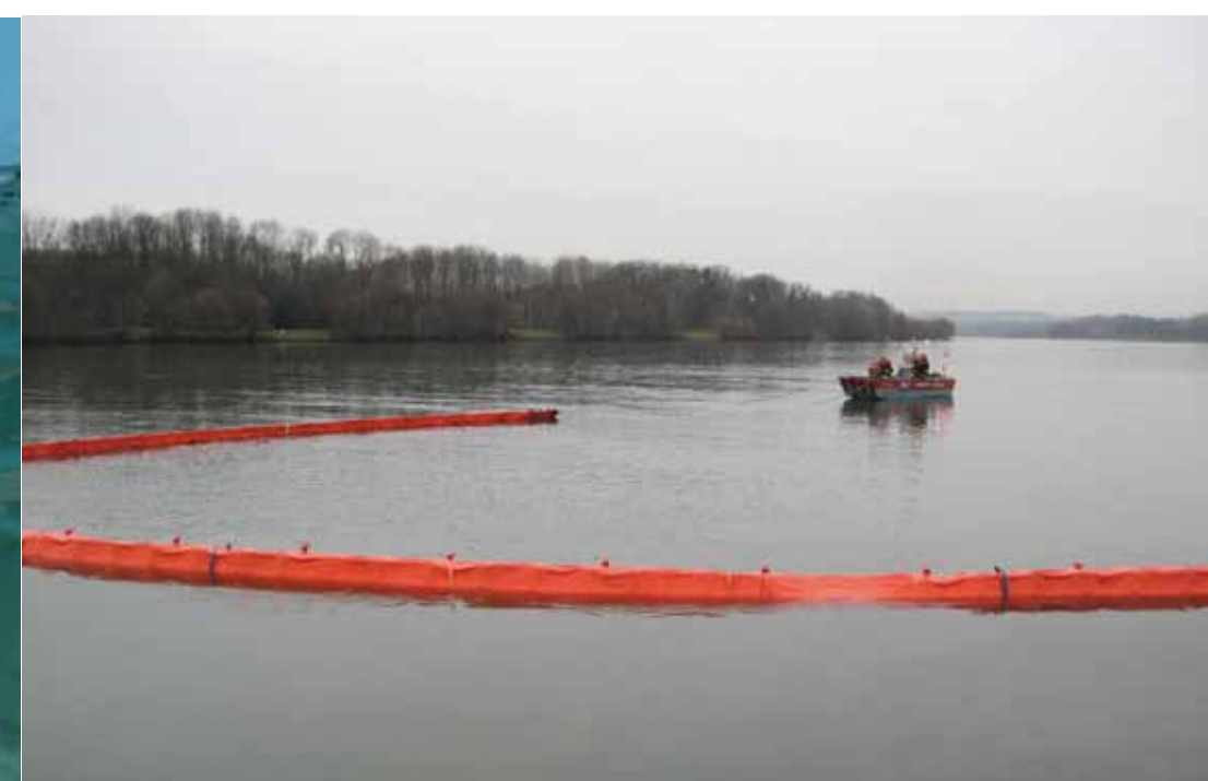
Errichten einer Ölsperre auf der Donau - Dezember 2014
